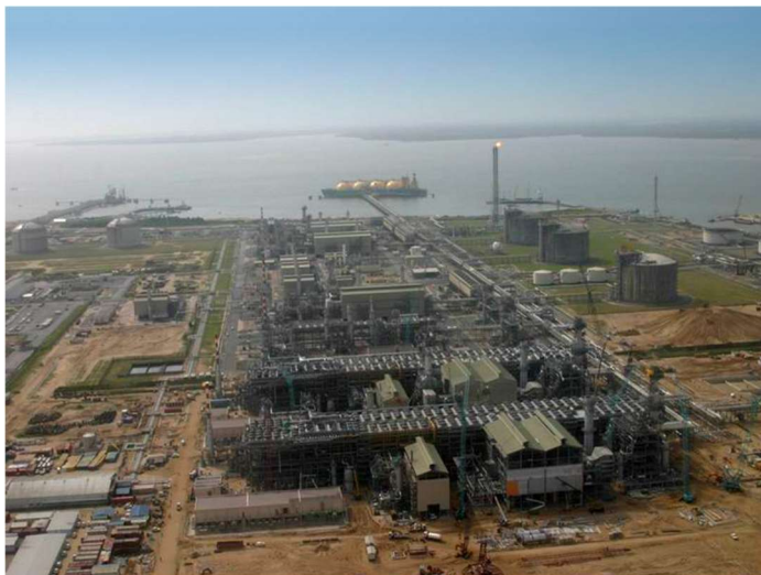
Vue de l'usine de liquéfaction NLNG de Bonny (Nigeria) en cours d'extension - au deuxième plan un méthanier en cours de chargement (Ph. A. Maréchal)
