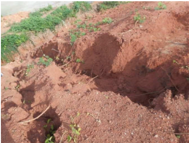
FIGURE 2.20 | RISQUE D'ÉBOULEMENT LIÉS AUX REMBLAIS INSTABLES (CAPAM).
