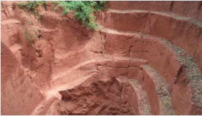
FIGURE 2.21 | NON-CONFORMITÉ DES PALIERS (CAPAM).
