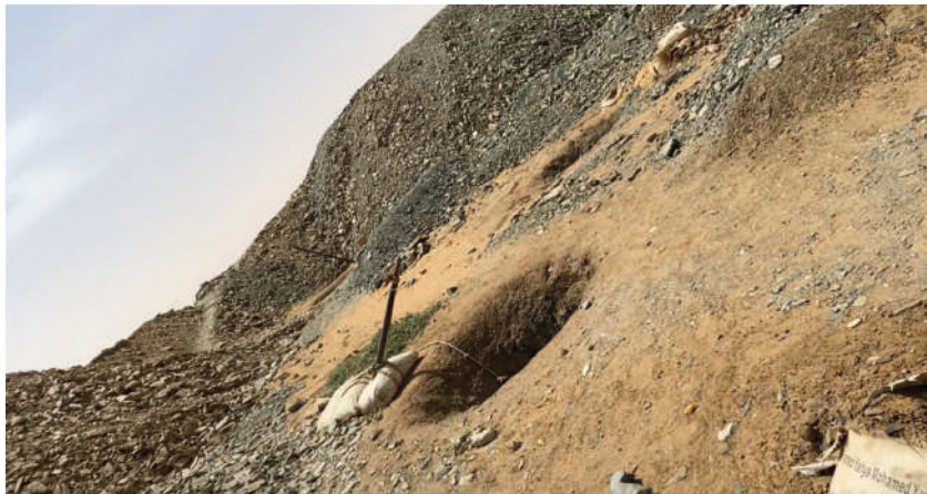
FIGURE 21.4 | FOSSE ABANDONNÉE APRÈS LA FIN DES TRAVAUX.
