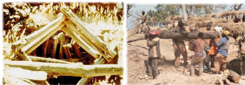
Figure 53 : Système de boisage utilisé pour le soutènement des ouvrages miniers (site de Bida, Burkina Faso).
