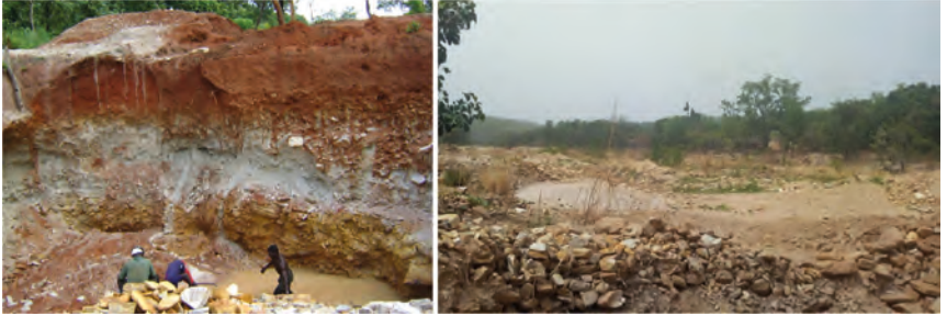
Figure 80 : à gauche : site d'exploitation artisanale de l'or ayant atteint une nappe phréatique super cielle à Kouaterna (Commune de Natitingou, Département de l'Atacora, Bénin). A droite : lit de la rivière « Perma » ensablé et modifié par l'exploitation artisanale de l'or à Perma (Commune de Natitingou, Département de l'Atacora, Bénin).
